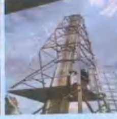
DA001 废气排放口
